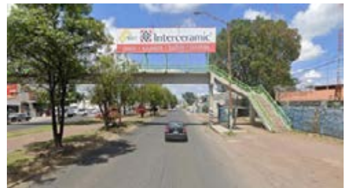
Puentes peatonales en el Municipio de Tulancingo
